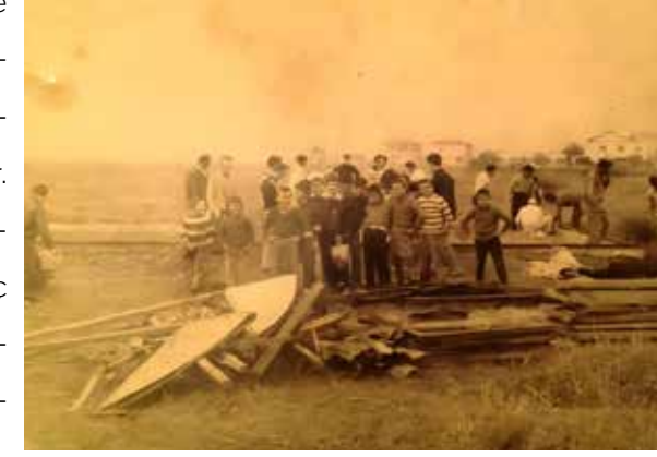
Kumsalda yapılan baraka inşaatında çalışan mahalle sakinleri. İç Kumsal. Kaynak: Coşkun Çalışbektas Arşivi
