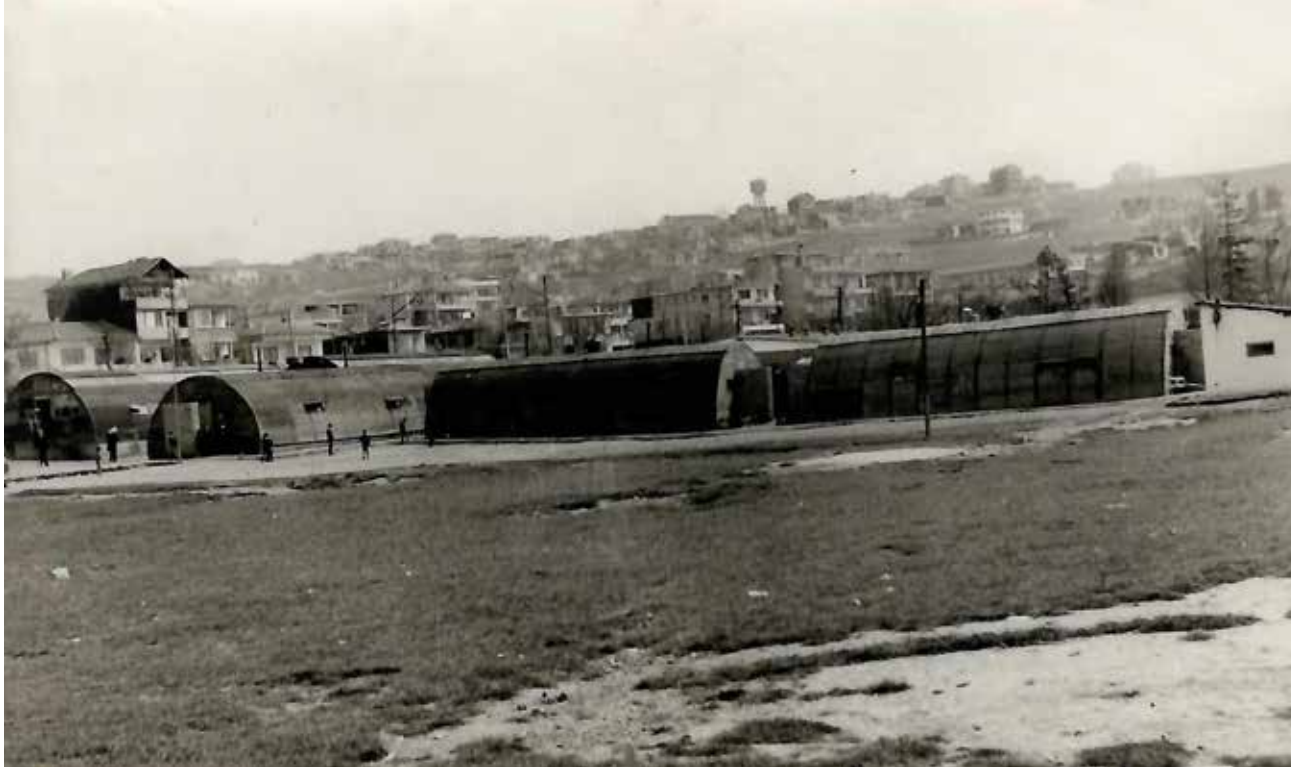
Kanarya'da dış kaplaması teneke, yer döşemeleri ahşap olan ve göl kenarında kurulu ilköğretim okulundan bir görünüm. 1967'li yıllar. Bülent Kurtar arşivi
