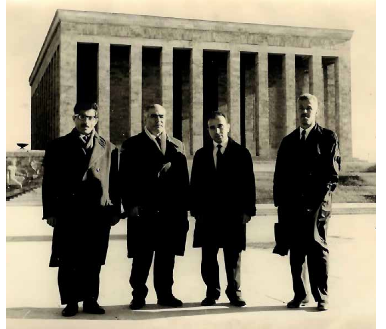
Kanarya İstasyonu'nun yapılması için Kanarya Güzelleştirme ve Yardımlaşma Cemiyeti yönetimi Anıtkabir ziyaretinde. Sol baştan: Mustafa Kapıcıoğlu, Zeki Tuncer, Nihat Özbal ve elektrikçi Mithat Bey. 14.01.1963
