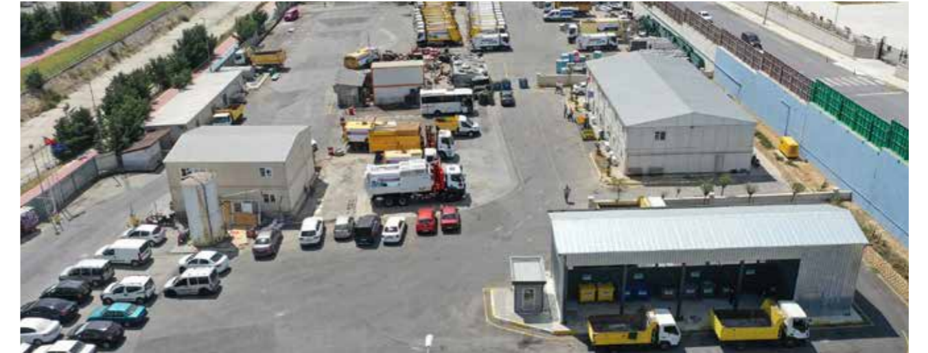
Geri Dönüşüm ve Katı Atık Merkezi. Fotoğraf: Küçükçekmece Belediyesi Arşivi
