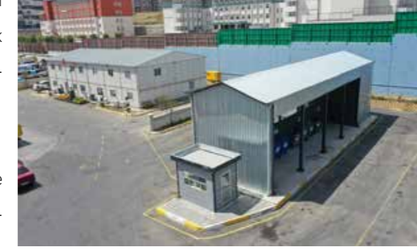
Geri Dönüşüm ve Katı Atık Merkezi Fotoğraf: Küçükçekmece Belediyesi Arşivi
