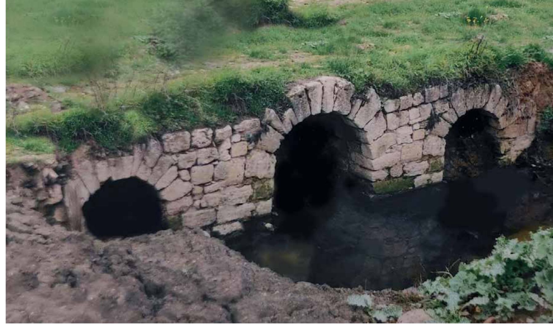
Taş Köprü, Fotoğraf: Küçükçekmece Kültür Varlıkları Envanteri", Yay. Haz. Dürdane Kaya, Küçükçekmece Belediyesi Kültür Yayınları, İstanbul: 2022, sayfa 109.
