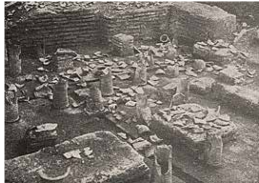
Rhegion Hamamı altındaki ısıtma sistemi Aziz Ogan ve Mansel 1942: Lev. XV Res. 26 (Küçükçekmece Belediyesi Kültür Varlıkları Envanteri)
