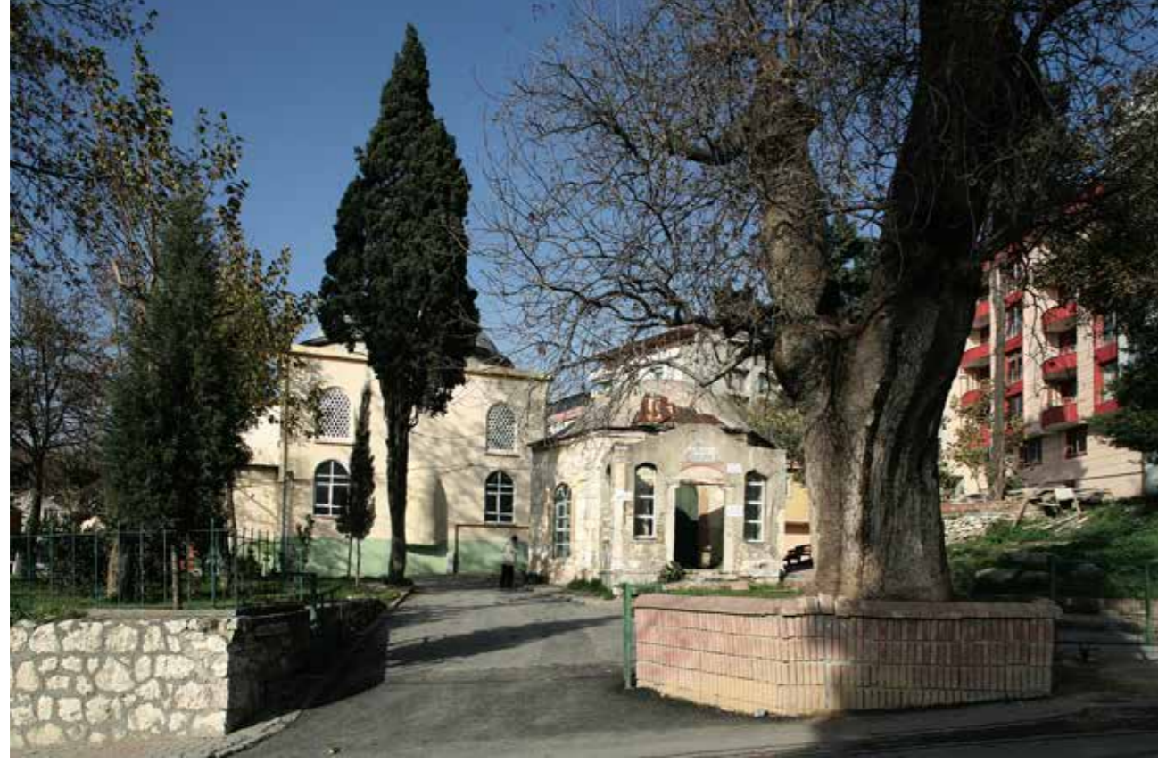
Abdüsselam Külliyesi (Küçükçekmece Belediyesi Kültür Varlıkları Envanteri)
